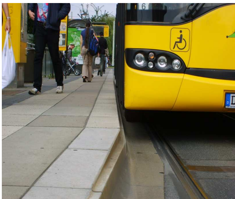
Rys. 7.5. Zalecane ukształtowanie krawędzi peronowej. Źródło: materiały własne TRAKO.
