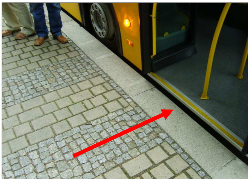
Rys. 7.7. Strefa wejściowa – inny rodzaj nawierzchni naprzeciwko pierwszych drzwi autobusu. Źródło: materiały własne TRAKO.
